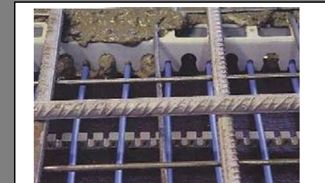
Abb. 51: Kapillarrohre in einer Stahlbetondecke
