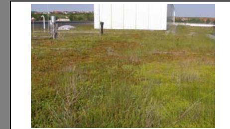
Abb. 6: Dachbegrünung eines Pilotprojektes in Berlin (aus KÖHLER & SCHMIDT 2008)
